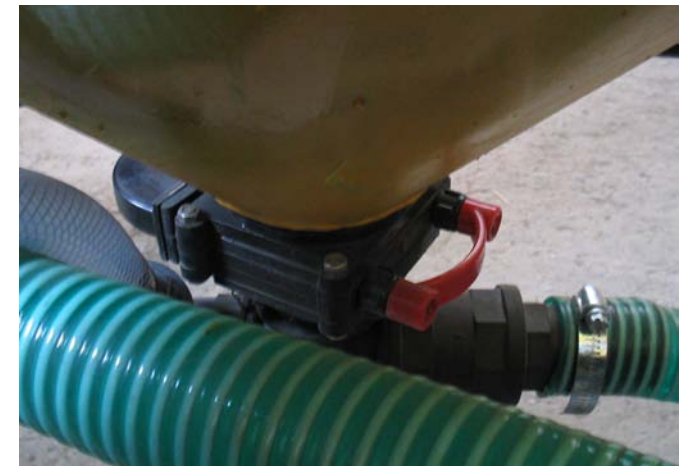
Опорожнение миксера (затворка открыта)
